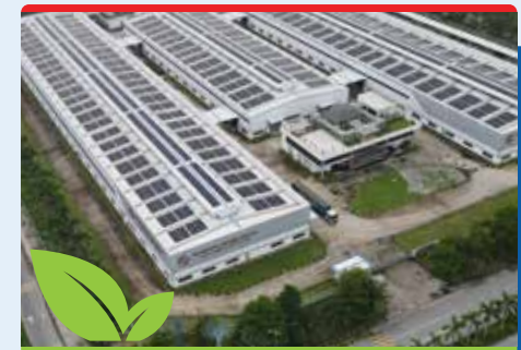
Dự án Dây Cáp điện Trần Phú
